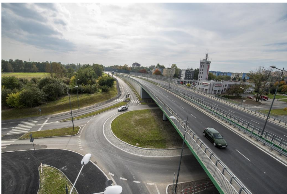
Fot. Wiadukt przy Al. Niepodległości. Źródło: UM Tychy
